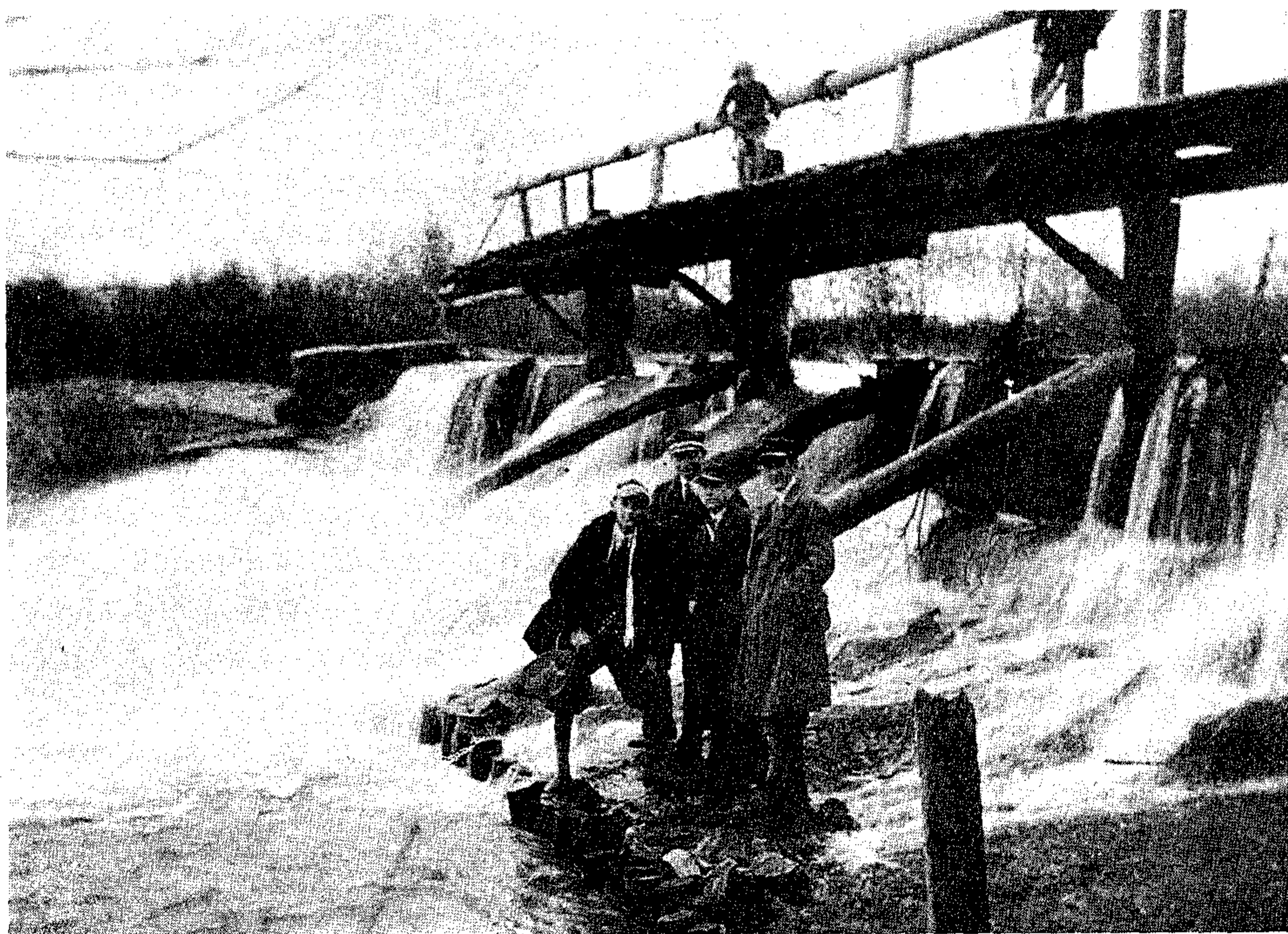
Jaz, czyli tama na rzece Skawince w czasie dużej wody
