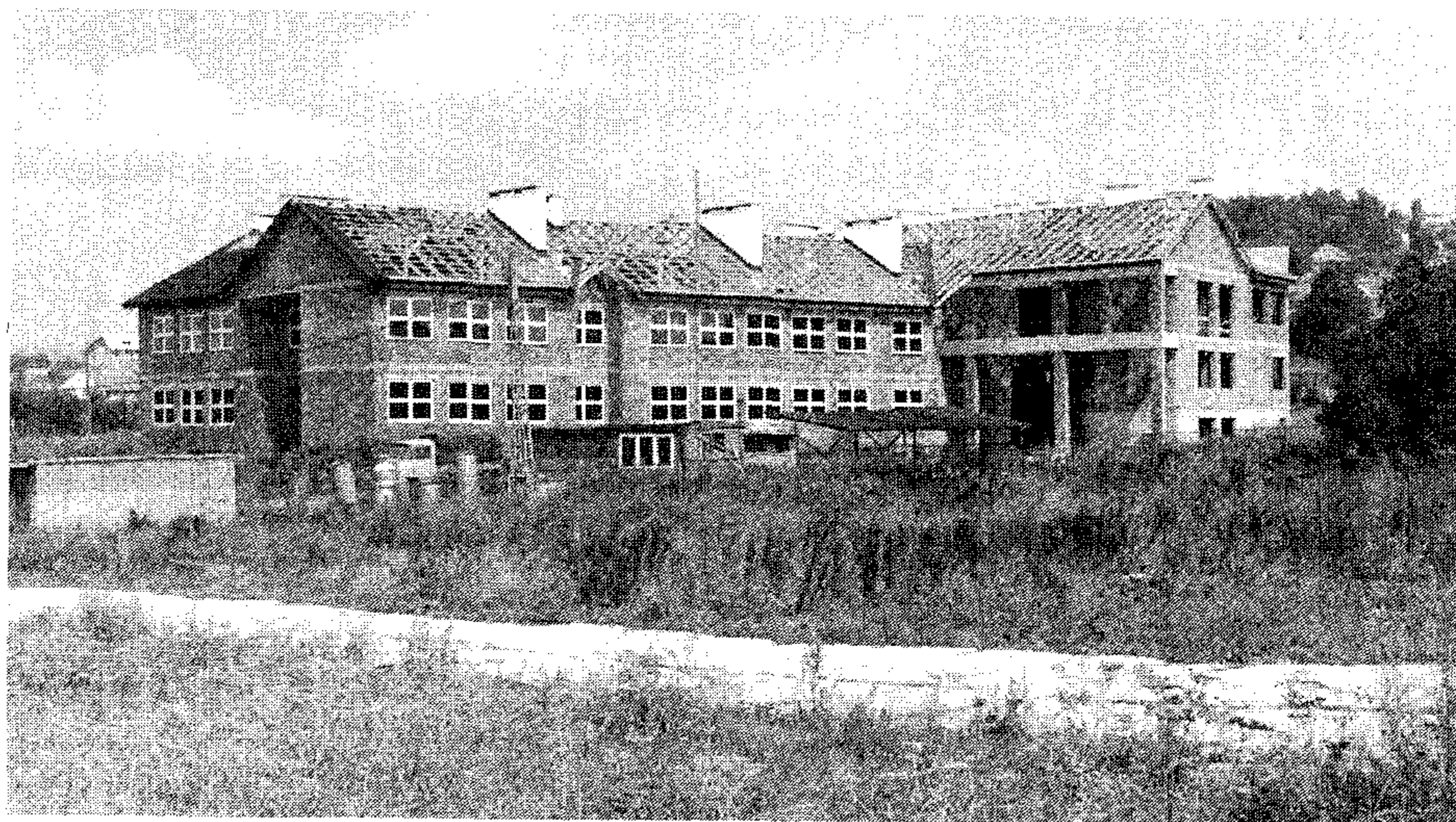
Szkola Podstawowa w Radziszowie w trakcie budowy
