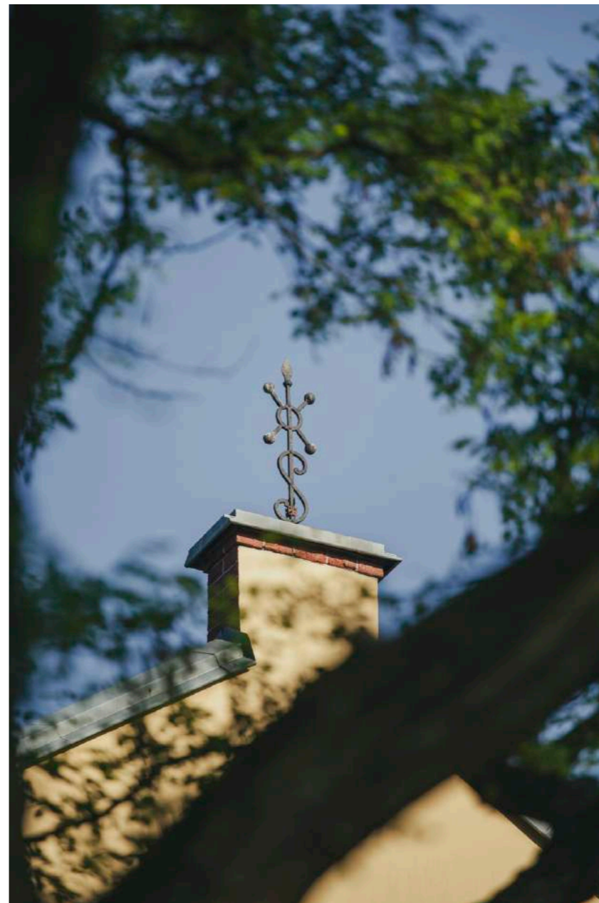
Pałac „Sokół” — element zwieńczenia ściany szczytowej zachodniej.
