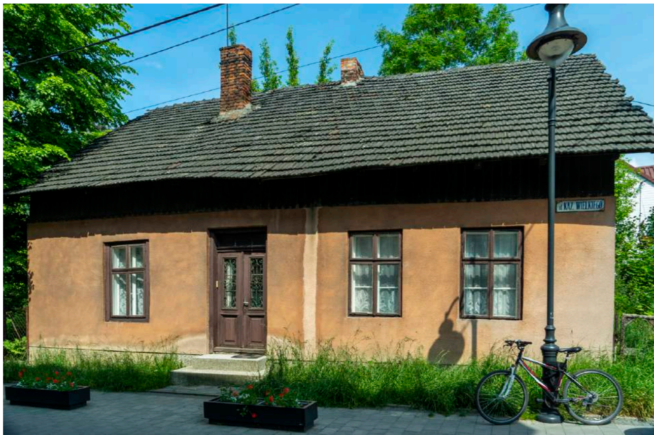
Ulica Kazimierza Wielkiego, dom Henryka Różyckiego (1873–1938) – autora powieści Umarła Babka w Skawinie (1911) oraz monografii miasta. Staraniem TPS w latach 2014–2019 ukazały się pozostające w rękopisach powieści: Rok 1863 w Skawinie , Baster oraz Gruzy . W roku 2020 na łamach „Informatora TPS” ukazały się obszerne fragmenty monografii (numer 100).
