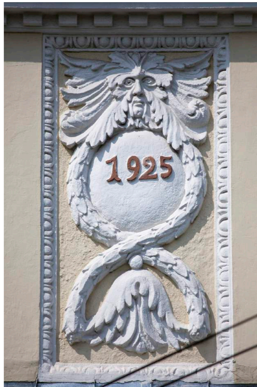
Element informacyjno-dekoracyjny na fasadzie dworu. Uwagę zwraca rozbudowana ornamentyka roślinna, ujęta w wieniec data roczna oraz twarz o spokojnym spojrzeniu.
